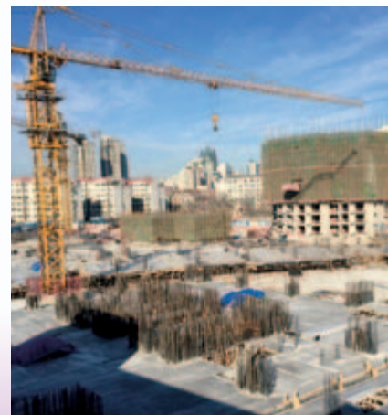
■ 綜合發展項目住宅大樓一上蓋工程進行中
