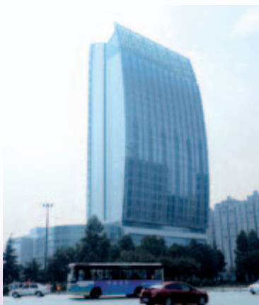
■ 綜合發展項目之第一階段之 五星級酒店富豪新都酒店 — 上蓋工程已完成
