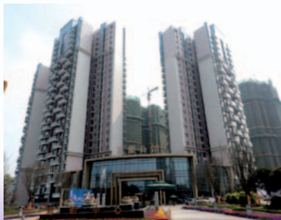
■ 成都綜合發展項目第一階段之三幢住宅大樓 — 接近竣工
