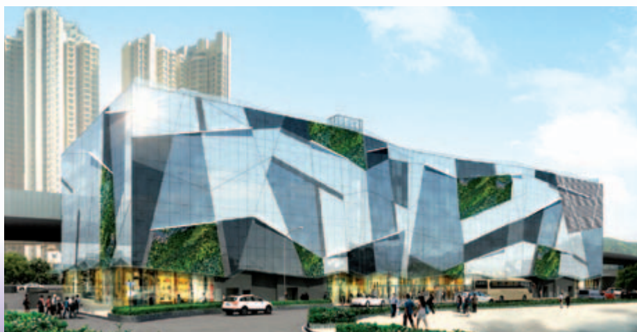
■ 位於新界沙田馬鞍山保泰街沙田市地段第 482 號之購物商場 — 地基工程已完成 (*)
