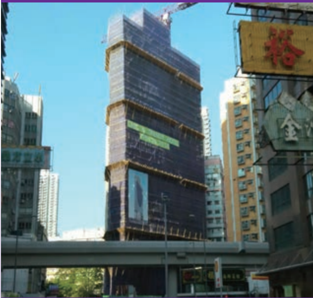
富蒼旺角酒店—上蓋建築工程進行中
