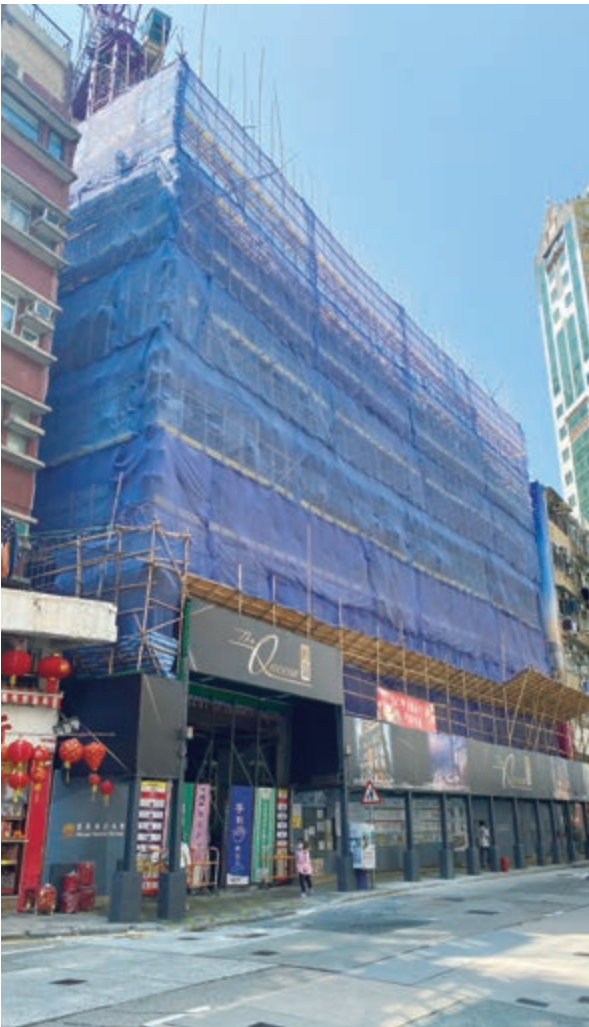
尚瓏 — 上蓋建築工程現正進行中
